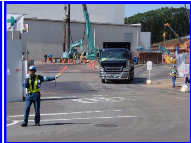
工事車両 誘導状況
