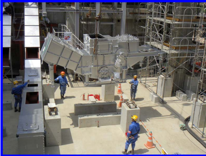
機器据付工事
