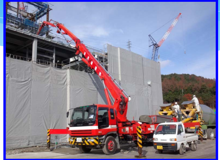
コンクリート工事
